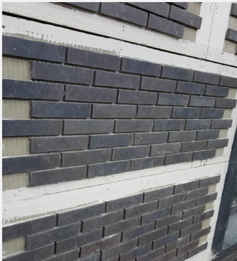
КЛИНКЕРНАЯ ПЛИТКА ПРИКЛЕЕННАЯ К АКВАПАНЕЛИ
