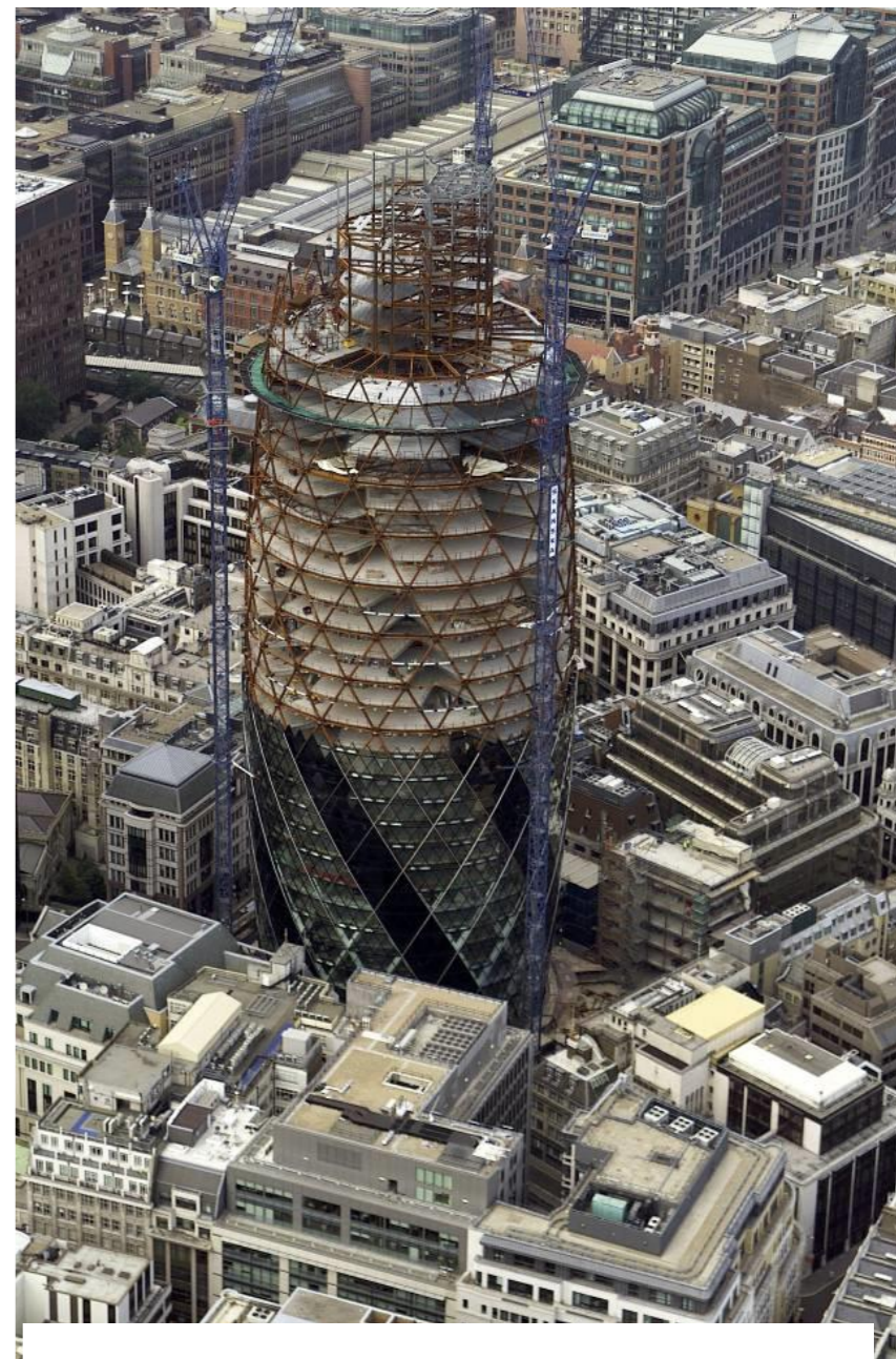
Строительство небоскреба Мэри-Экс в Лондоне, конструкция которого выполнена в виде сетчатой оболочки с центральным опорным основанием
